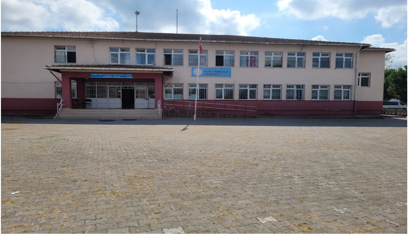
2012Yılında İnşa Edilen ve Halen Kullanılmakta Olan Okul Binası
